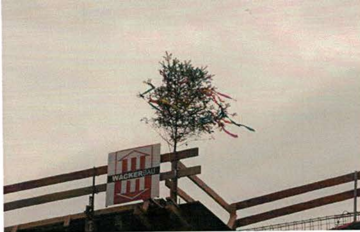
Richtfest am Erweiterungsbau des Kreisseniozenentrums Kenzingen
